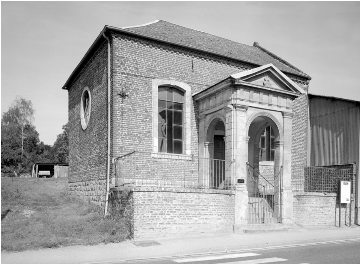
Vue de trois-quarts, depuis le sud.
