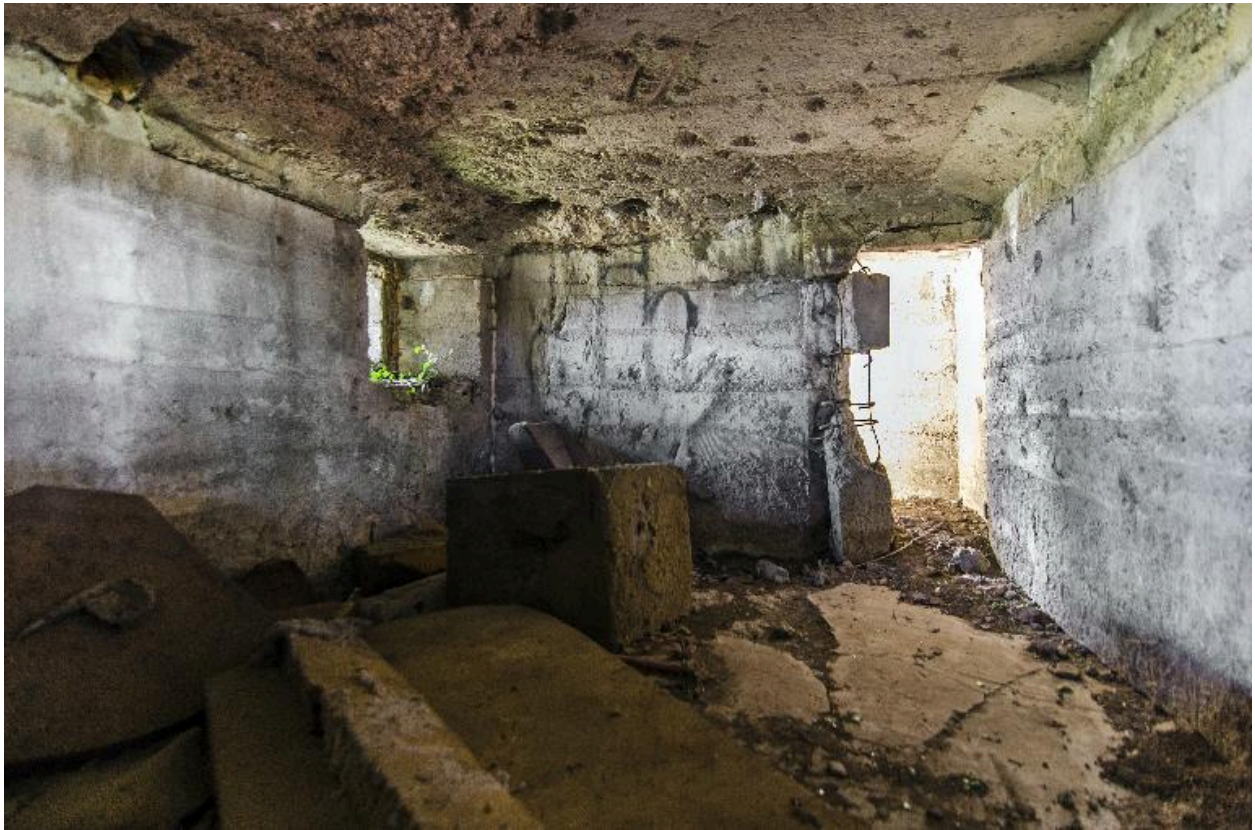
Vue intérieure en enfilade vers le sud
