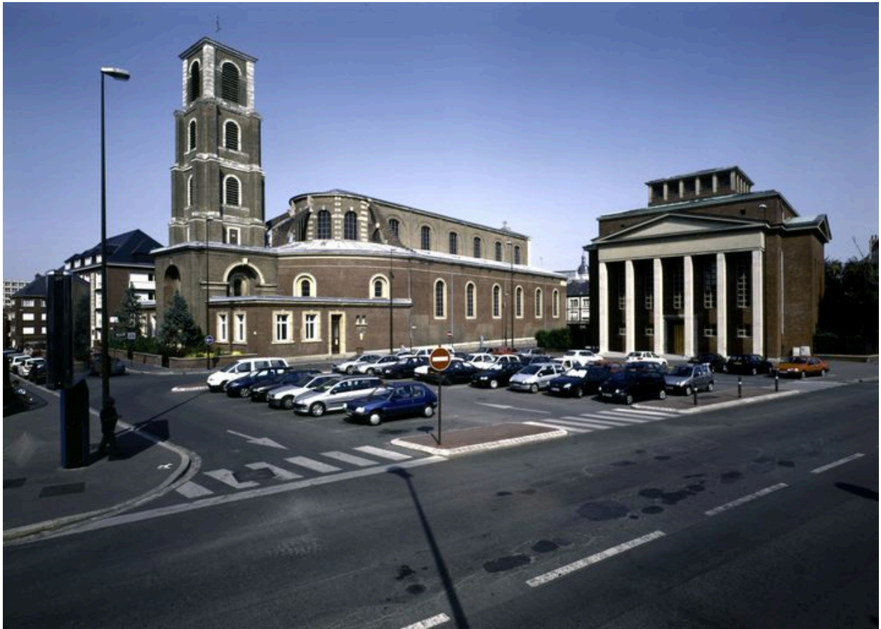
Vue de situation, depuis le sud-ouest.
