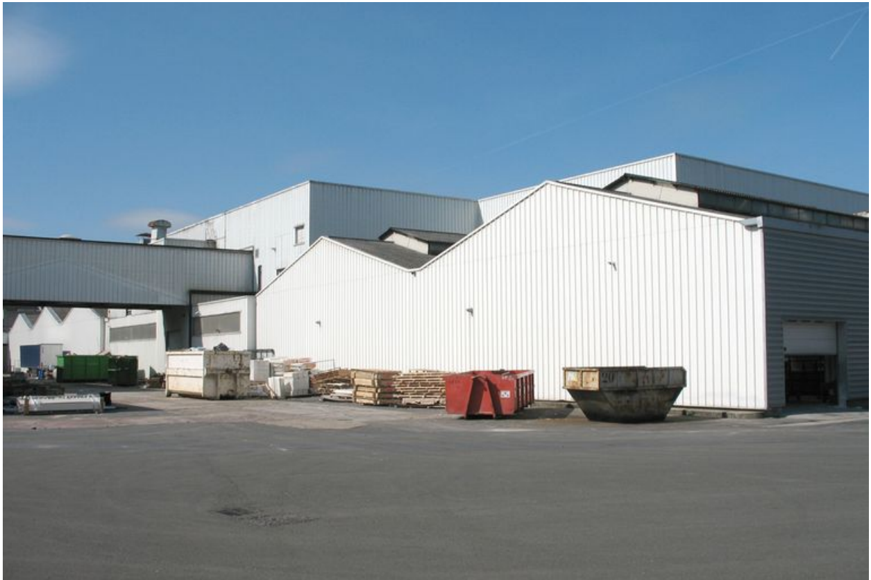
Anciens magasins de stockage des pièces.
