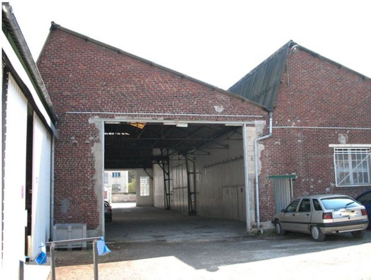
Les travées en sheds des ateliers de fabrication.
