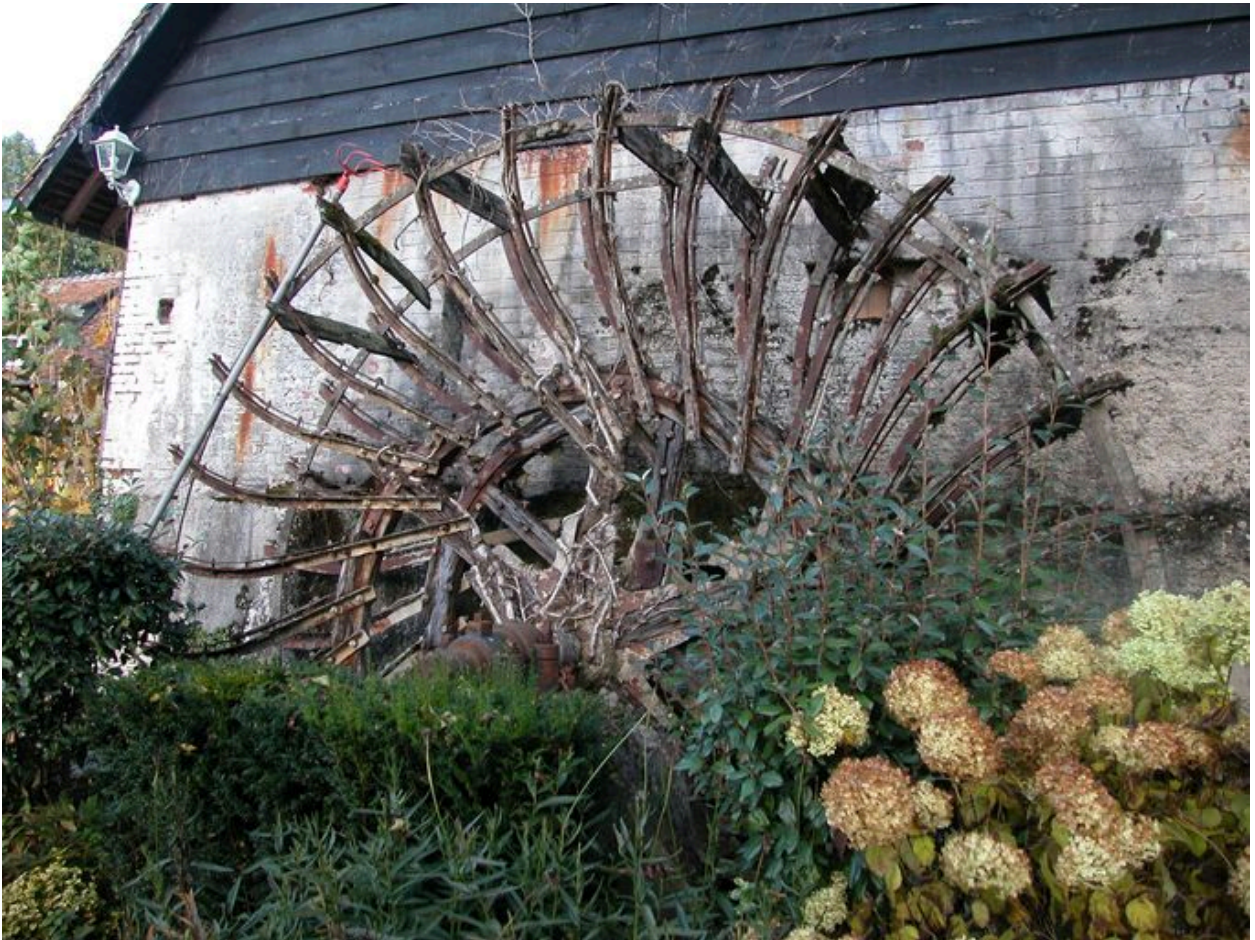
Vue de la structure de la roue hydraulique.
