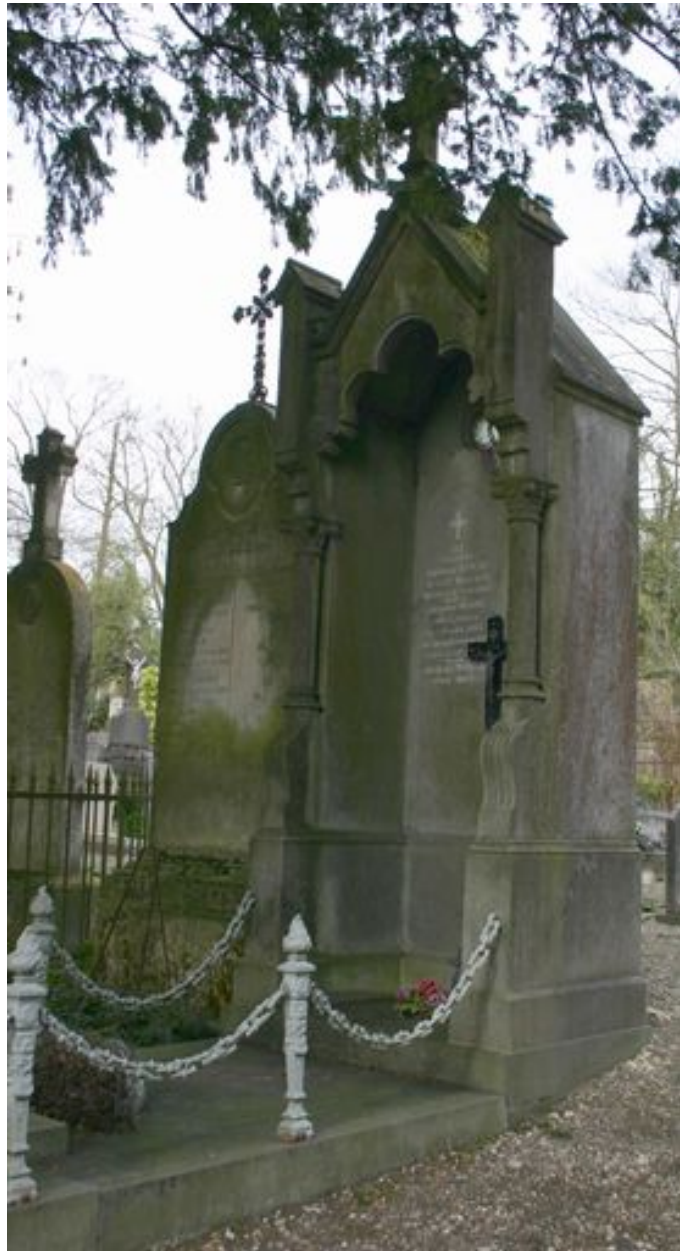
Vue rapprochée depuis le côté.
