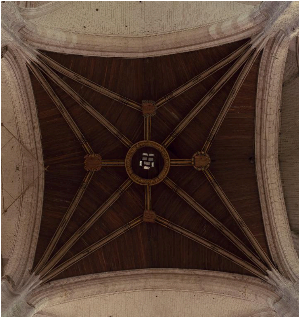
Vue d'une fausse voûte à la croisée du transept, reconstruite après l'effondrement de 1573.
