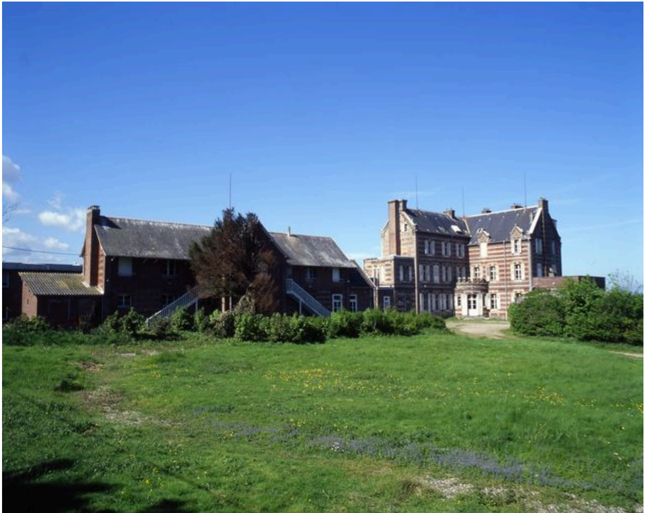
Vue d'ensemble du corps de logis et des dépendances.
