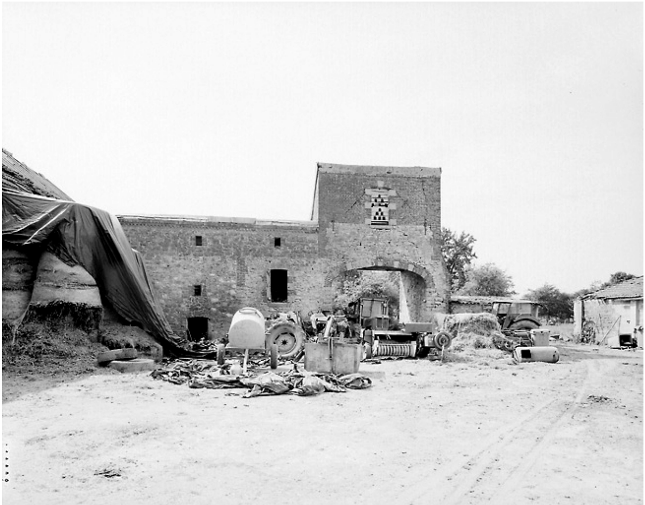
Vue du pigeonnier-porche de la ferme située 11 rue d'Avesnes.
