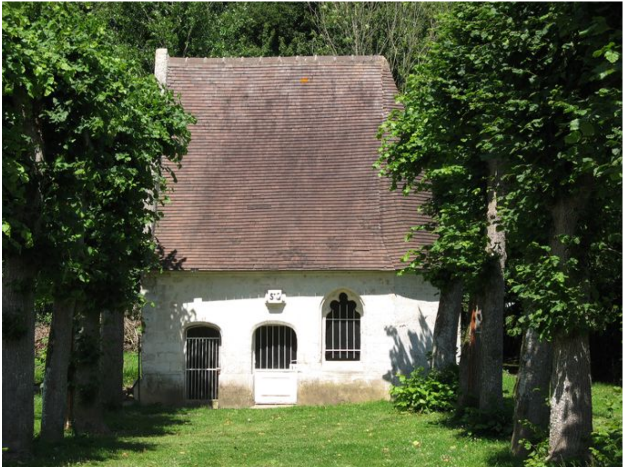
Vue depuis le sud.
