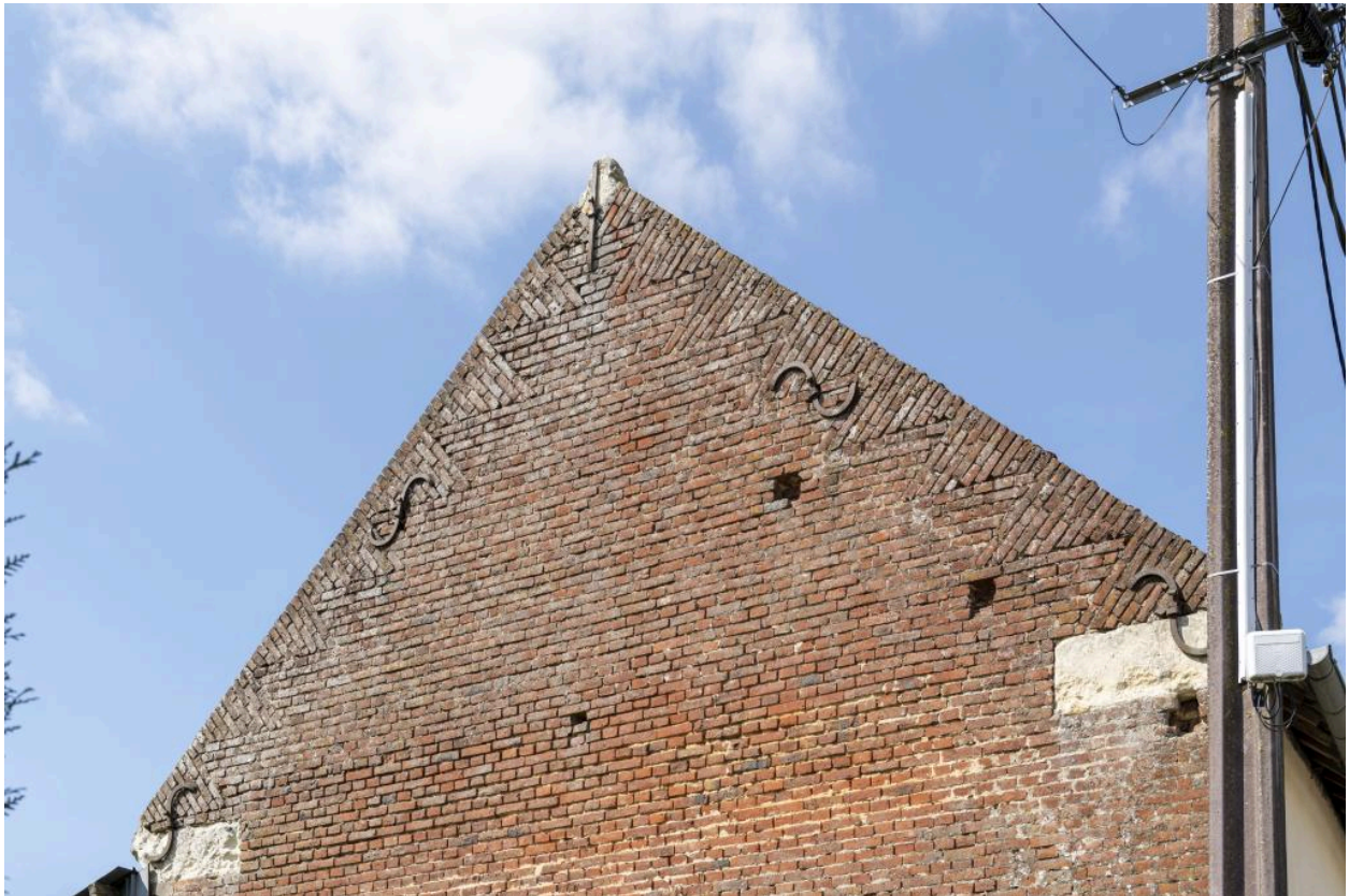
Pignon en brique avec couteaux picards, logis de l'ancien presbytère, n°41 rue Principale, vue depuis le nord.
