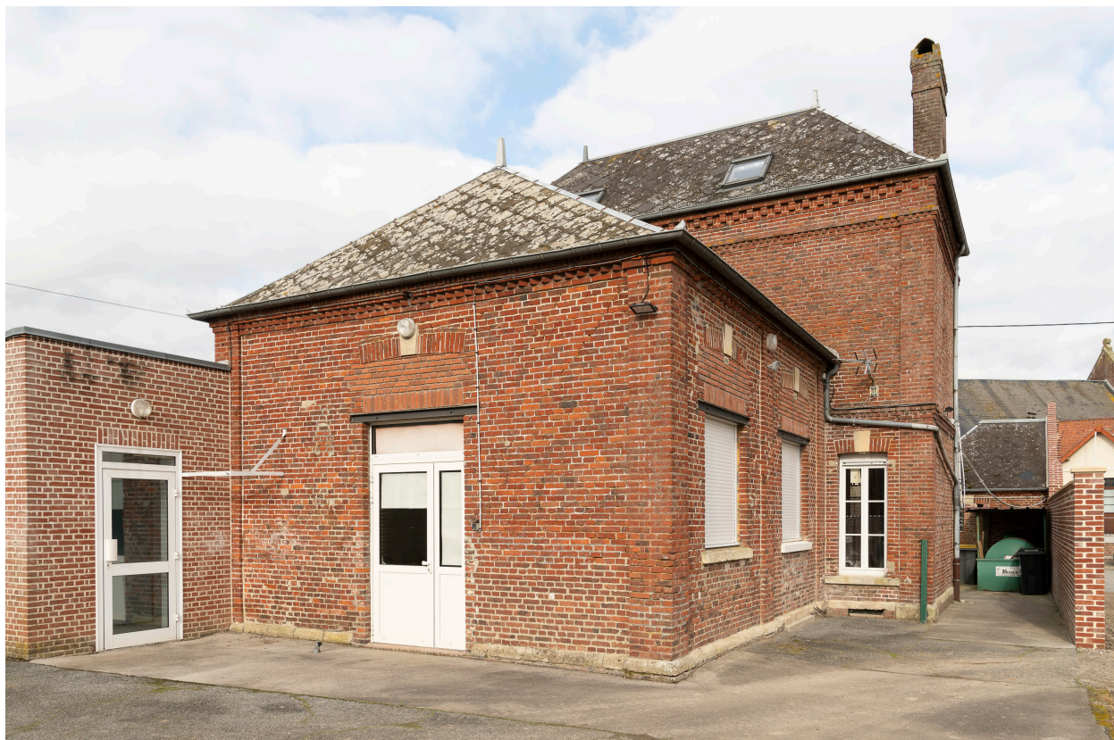
Ancienne école, vue prise depuis le sud.
