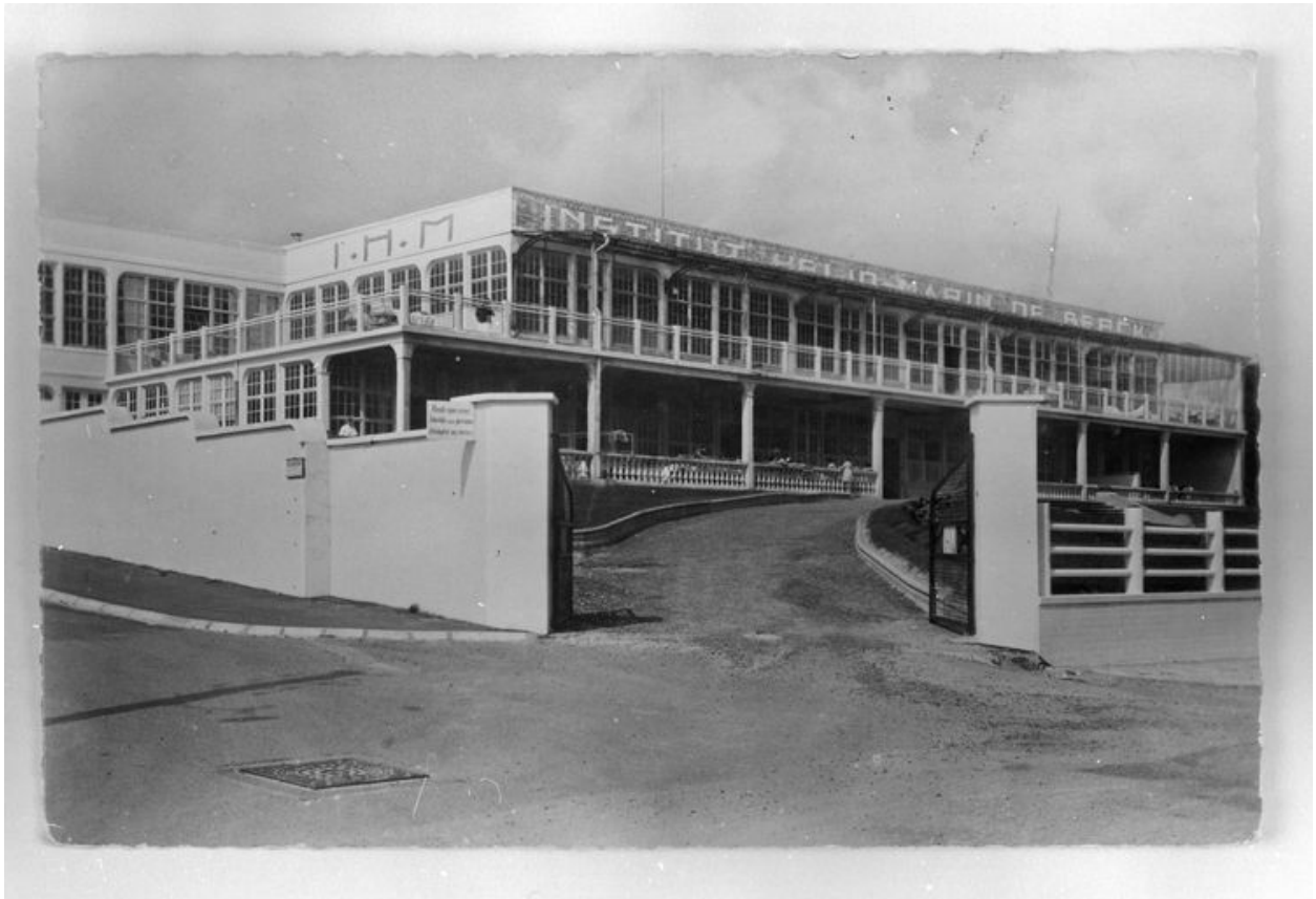
Bâtiment affecté aux femmes dit institut hélio-marin B, élévation antérieure, vue générale. Carte postale, années 1920-1930.
