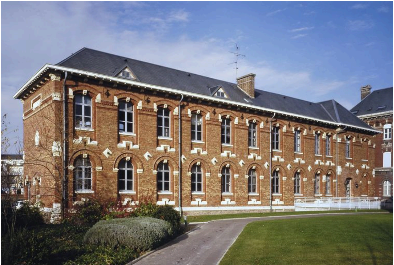
Élévation postérieure du bâtiment sur la cour d'honneur.
