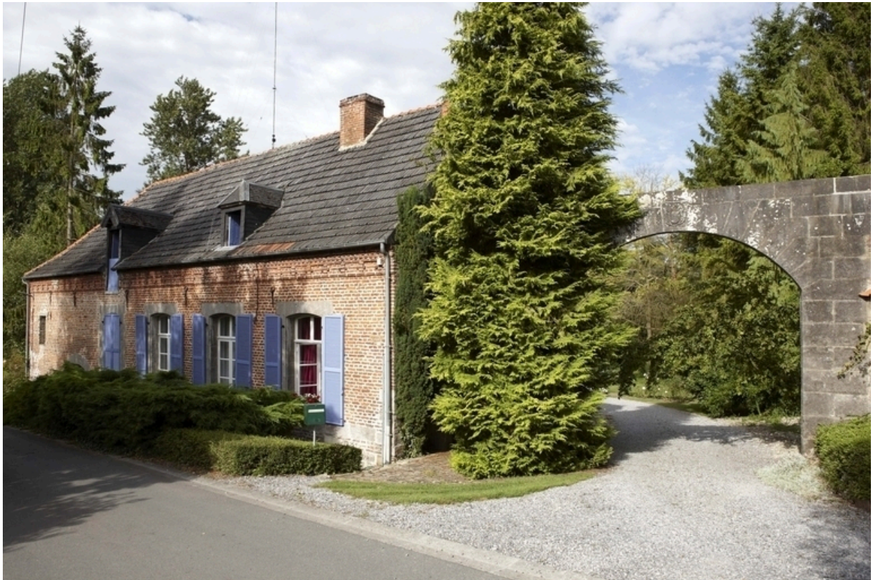
Vue du moulin et du porche.
