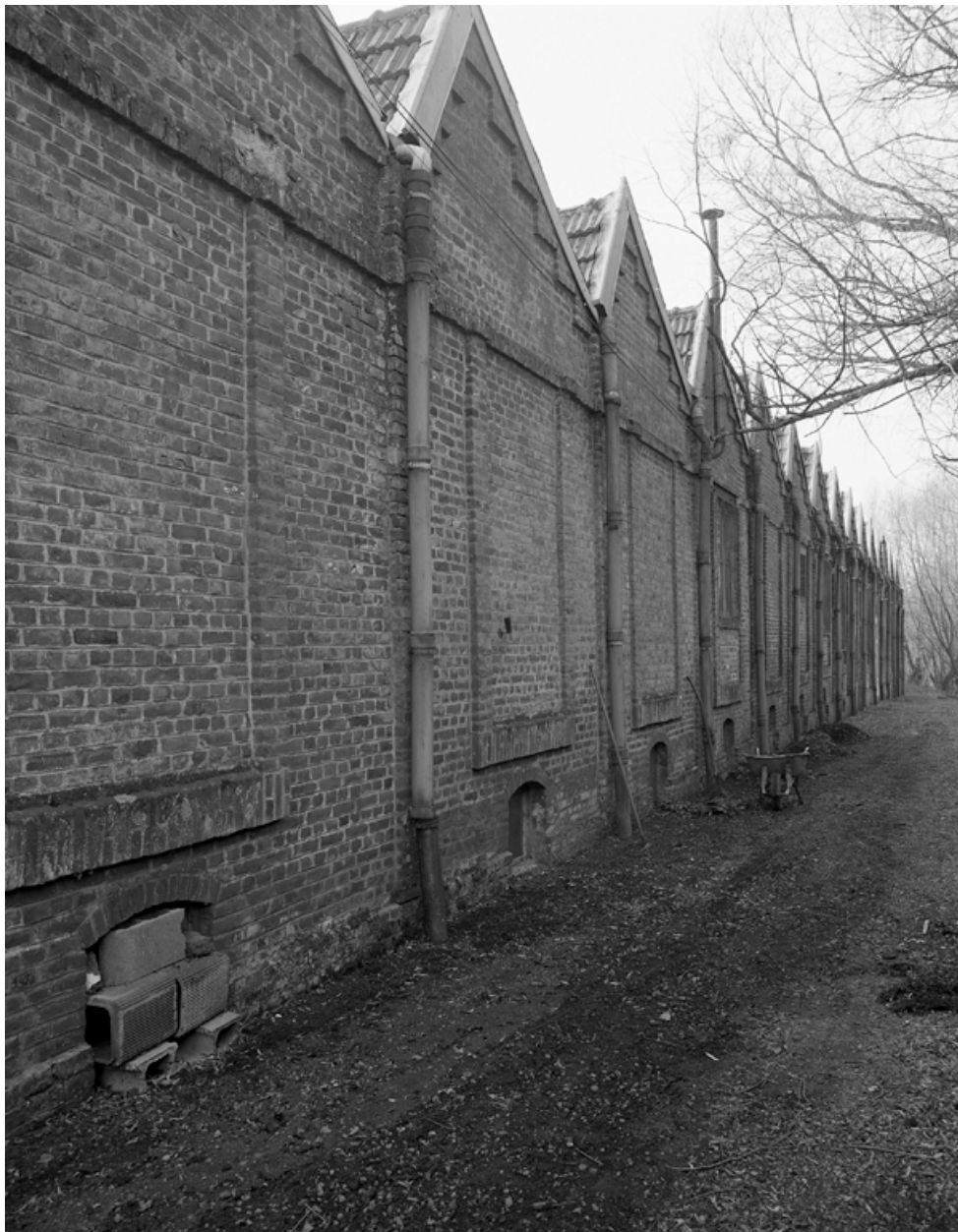
Atelier de fabrication, élévation nord-ouest.
