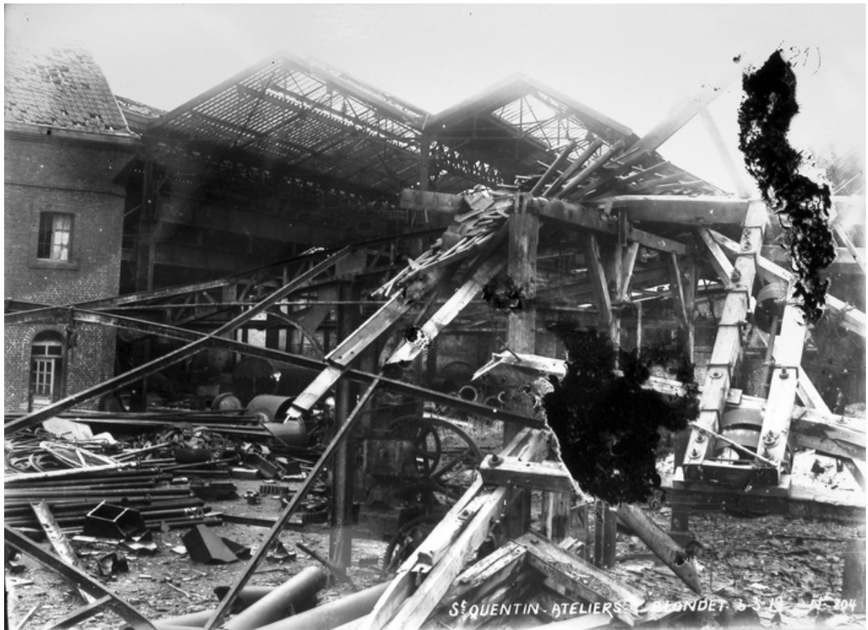
Les ateliers de chaudronnerie en 1919 (AD Aisne).
