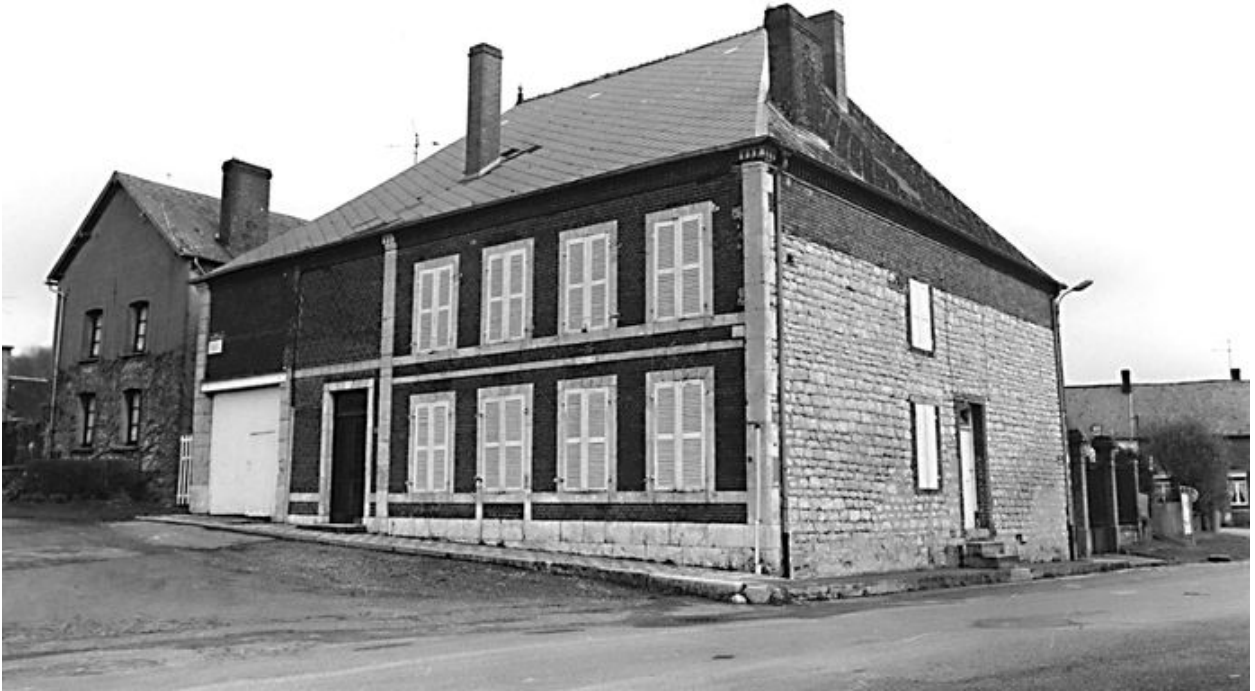
Vue générale depuis le sud-est, avant restauration.
