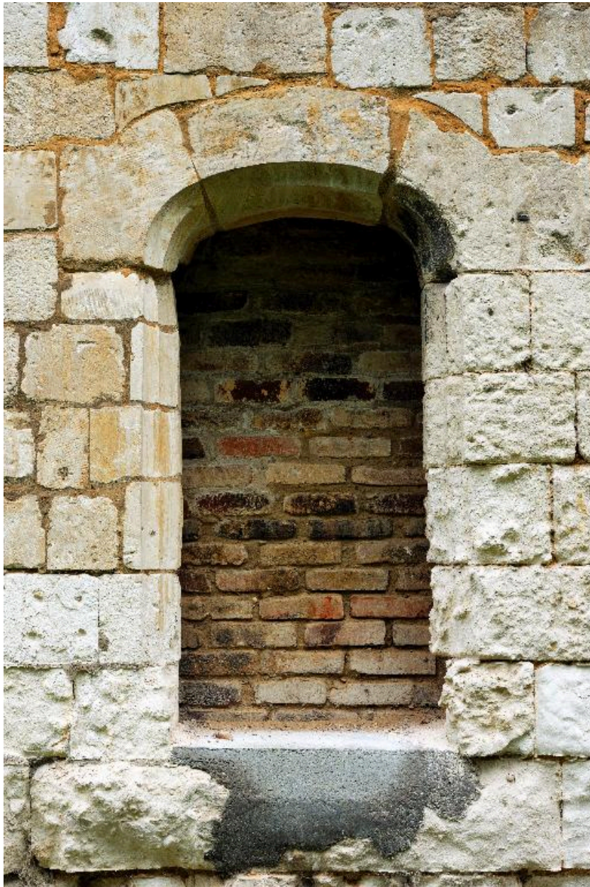
Baie murée d'un bâtiment prioral.
