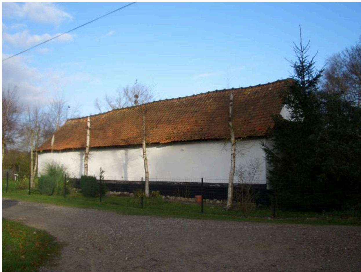
Vue postérieure des dépendances.
