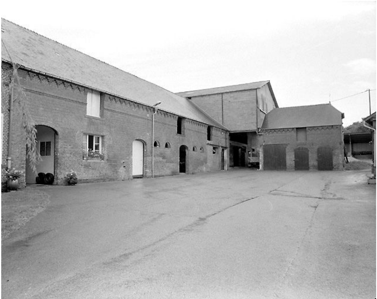
Etable à vaches attenante au logis et grange.
