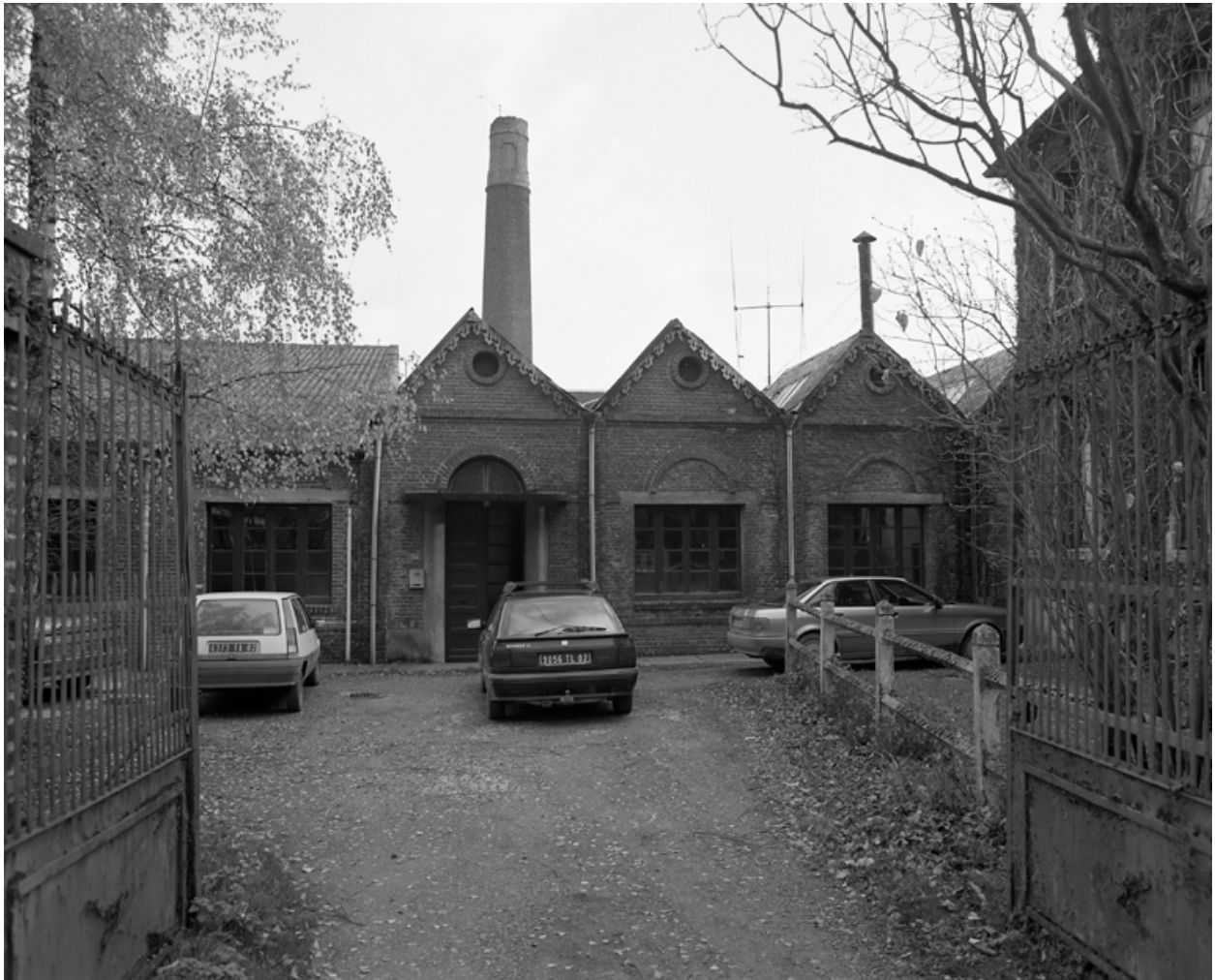
Entrée de l'usine : vue partielle de l'élévation sur rue de l'atelier de fabrication.
