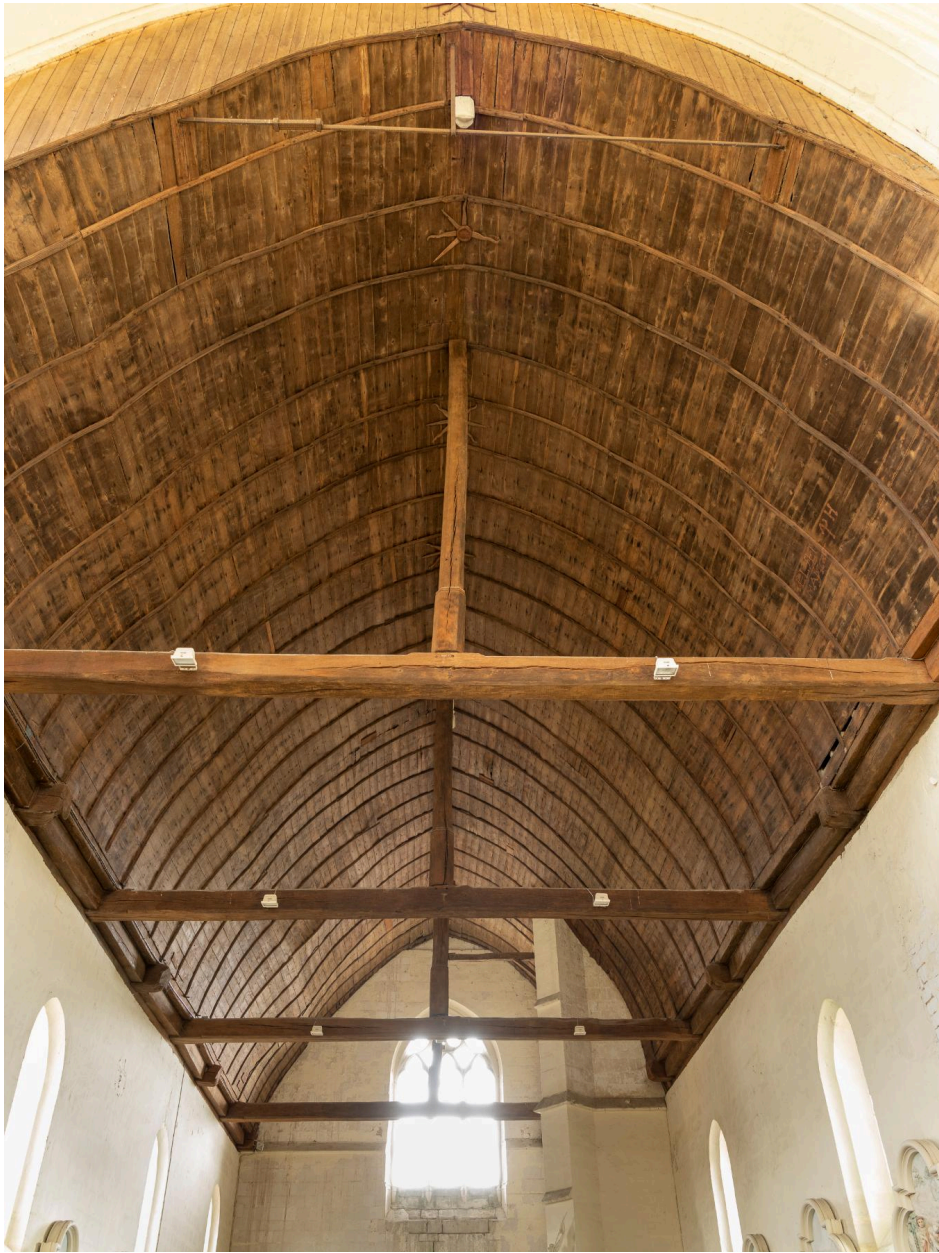
Charpente de la nef depuis le chœur.
