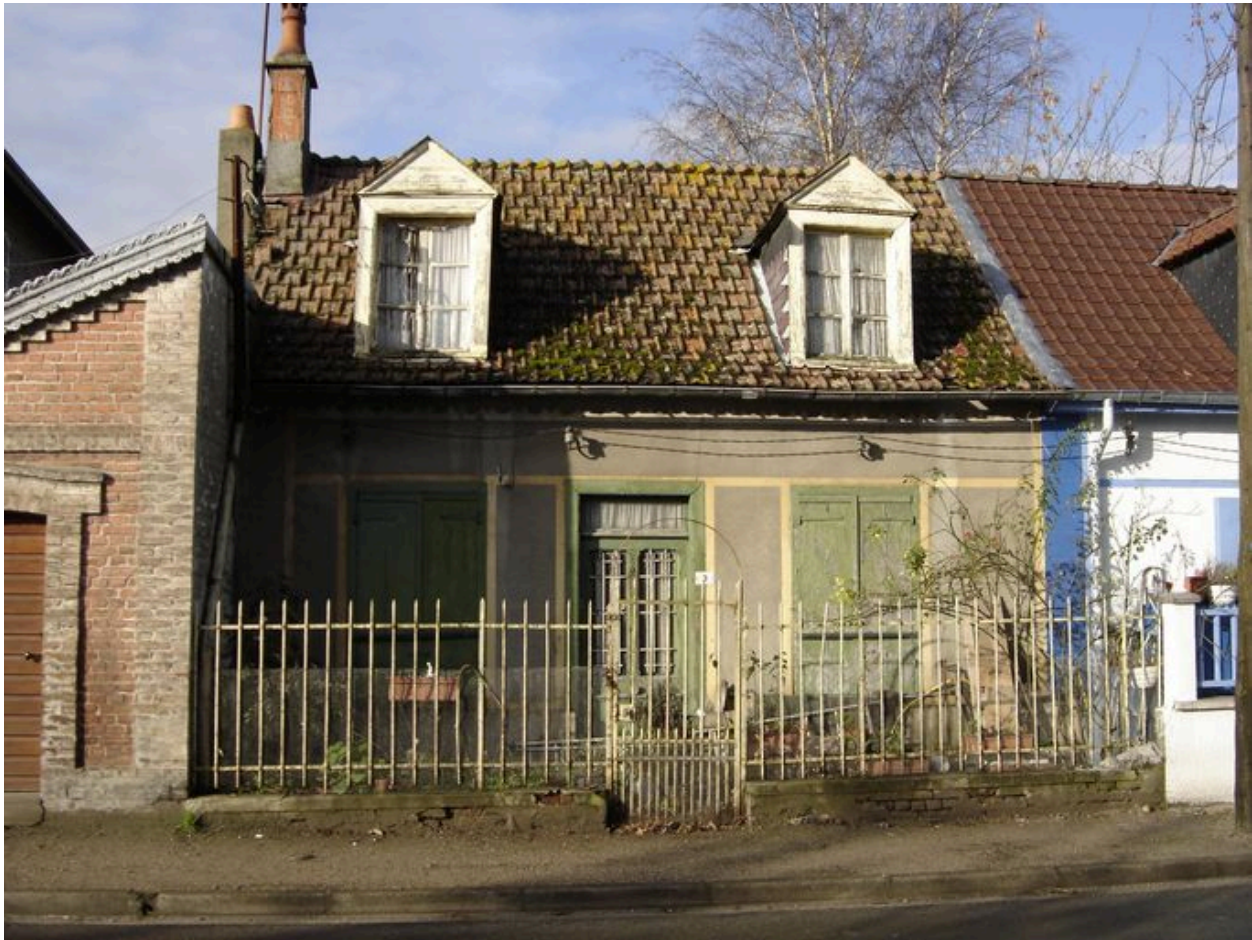
Vue du 3 rue du Général Leclerc.
