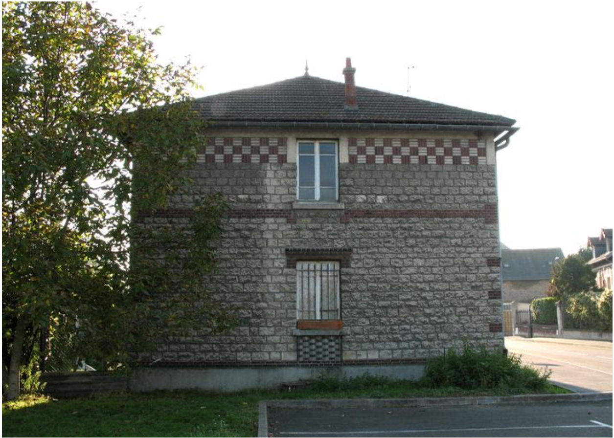
Mur pignon nord-est.
