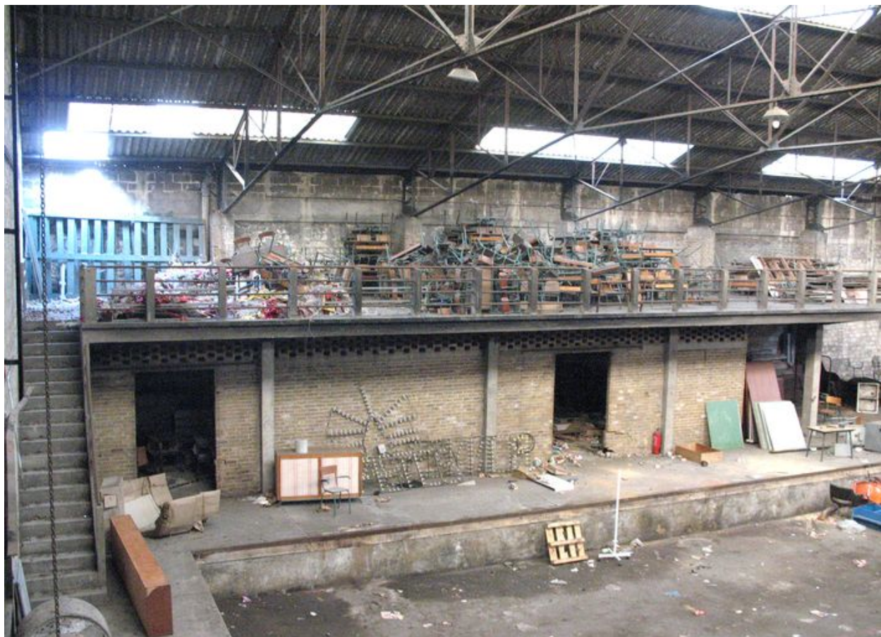
Quai de transbordement de la grande halle.
