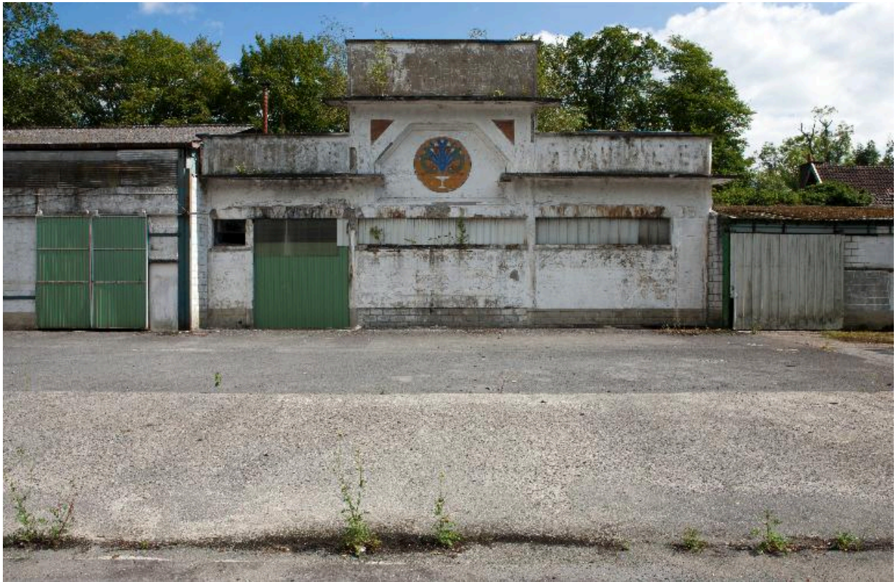
Vue générale de l'ancienne usine de mise en bouteilles des eaux minérales.
