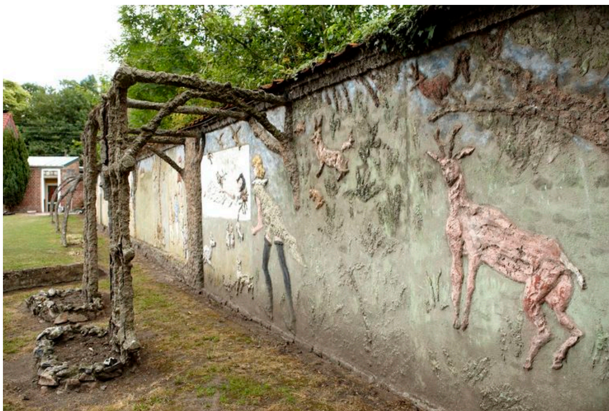
Palissade du jardin, vue partielle.
