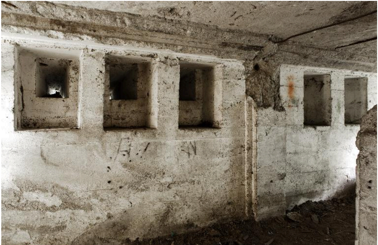
Créneaux de fusillade, vers l'ouest
