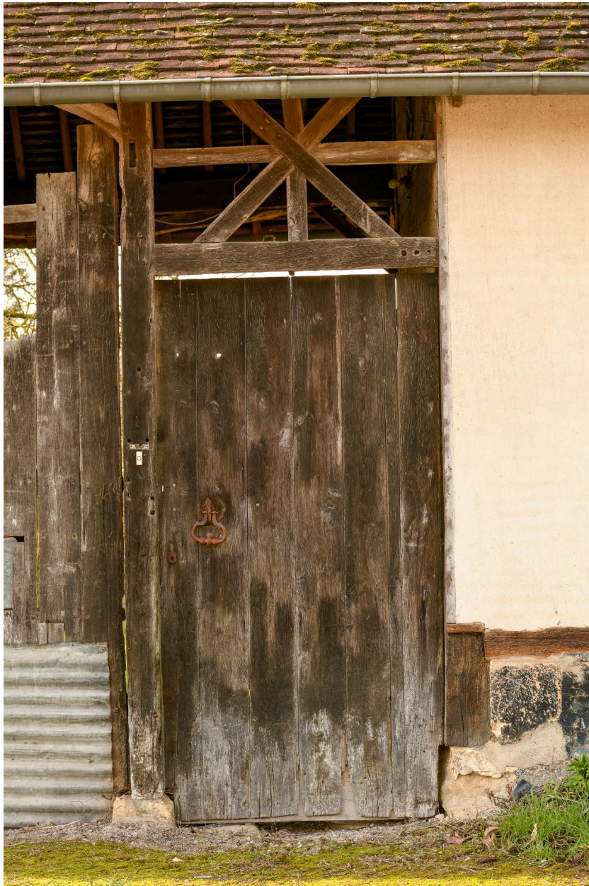
Détail : entrée piétonne et imposte ajourée, n°4 rue Mariette.
