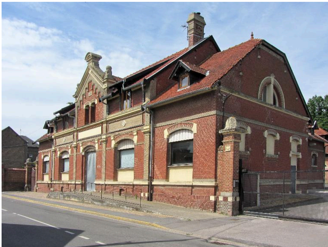
Façade sur rue, vue des trois quarts.
