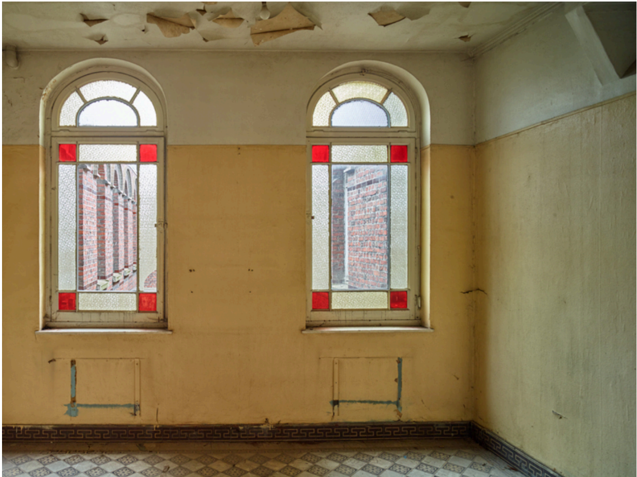
Bâtiment central, premier étage. Logement du directeur : vue de la chambre.
