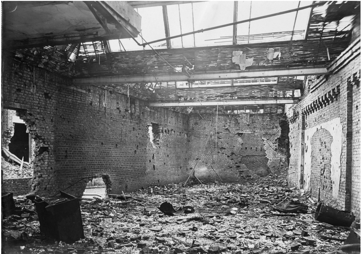
Vue intérieure du magasin industriel, par L. Maréchal, 1918-1919 (AD Aisne).
