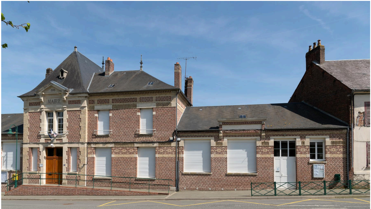
Ancien groupe scolaire et mairie ("1913"), n°5 de la rue Saint-Pierre, vue prise depuis l'ouest.
