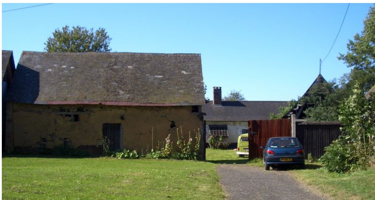
Vue générale depuis la place.
