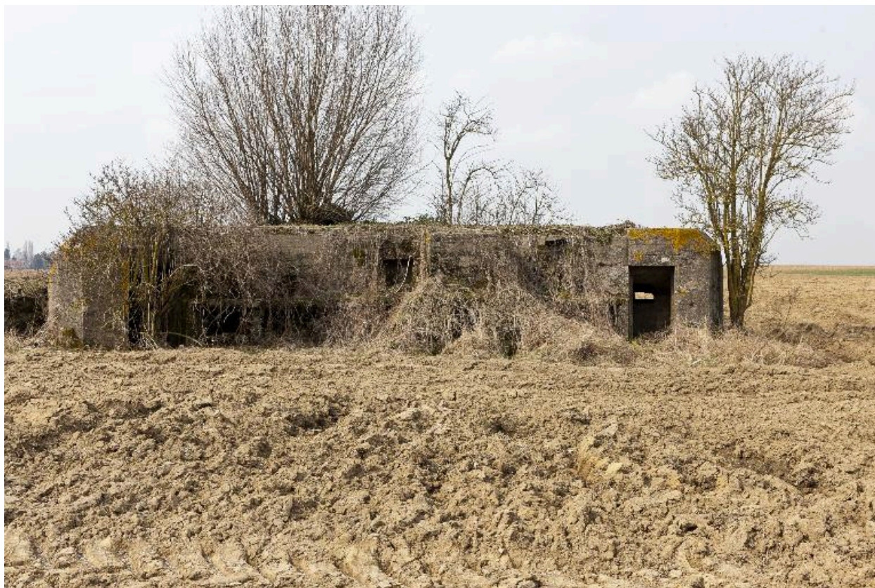
Vue vers le nord-ouest
