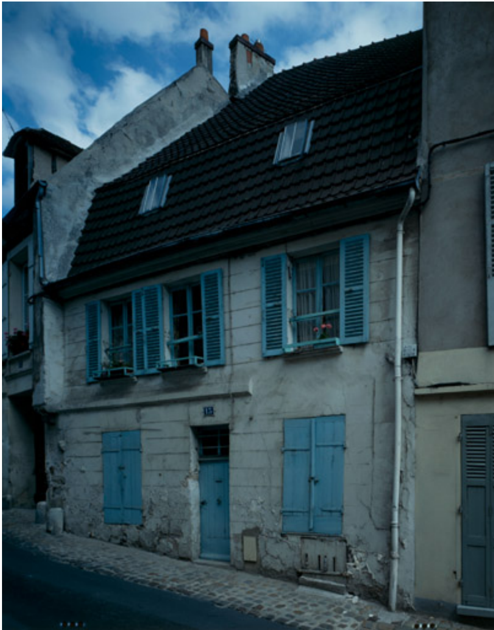
Maison, 15 rue du Château.
