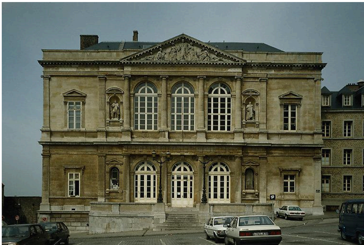
Vue générale de la façade.
