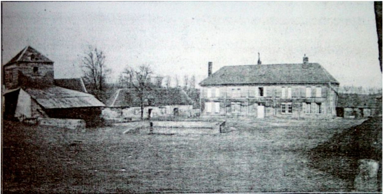
Vue ancienne du logis (coll. part).
