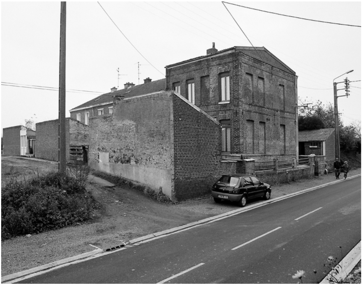
Vue générale de l'ancienne caserne de douanes, rue Molière.
