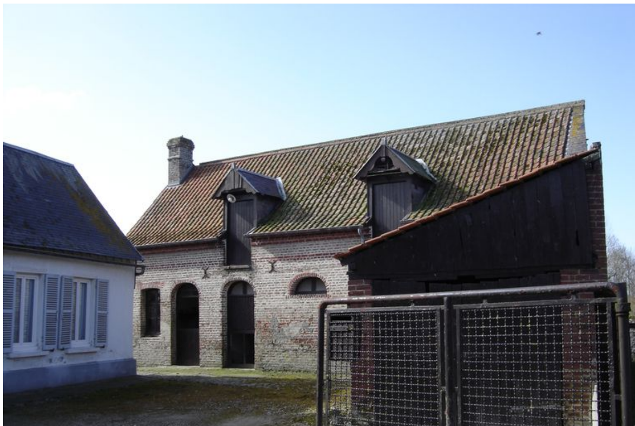
Vue des écuries.
