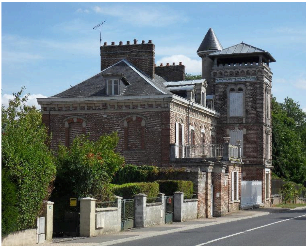
Vue de situation, depuis le village.
