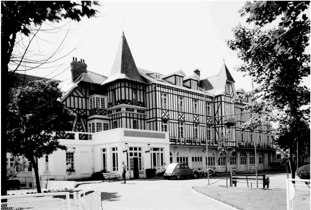
Vue générale, élévation rue Eugène-Trigoulet, en 1981.
