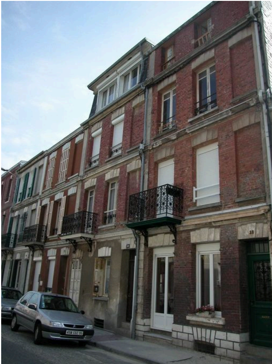
Vue d'ensemble des quatre logements.
