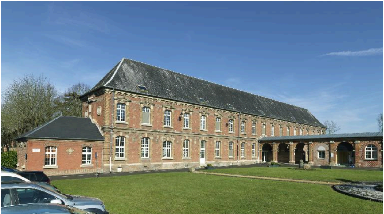
Ancien pensionnat. L'ancien pavillon des femmes.
