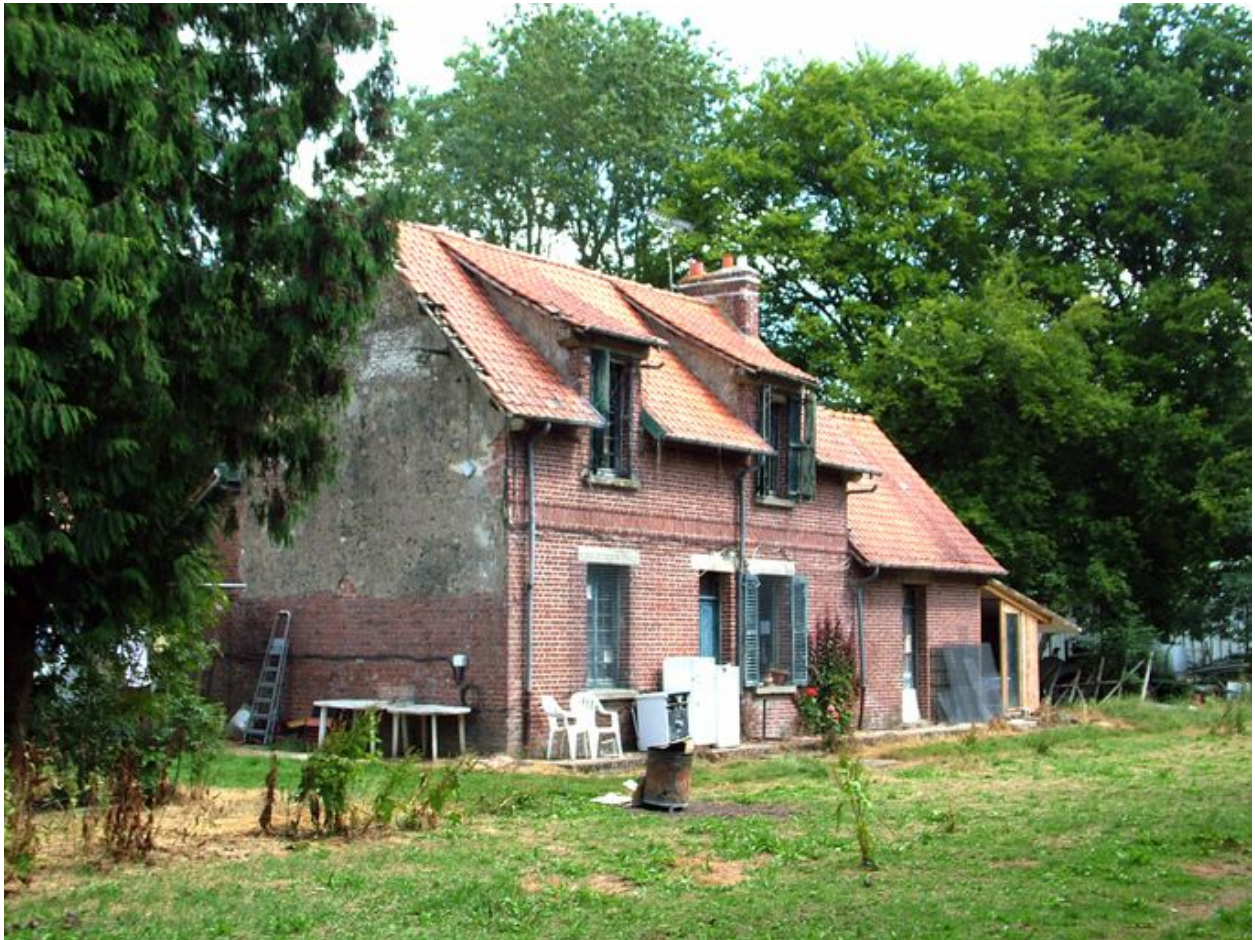
Maison forestière dite Maison Rouge, en lisière du bois de Ribeaucourt à Fransu.
