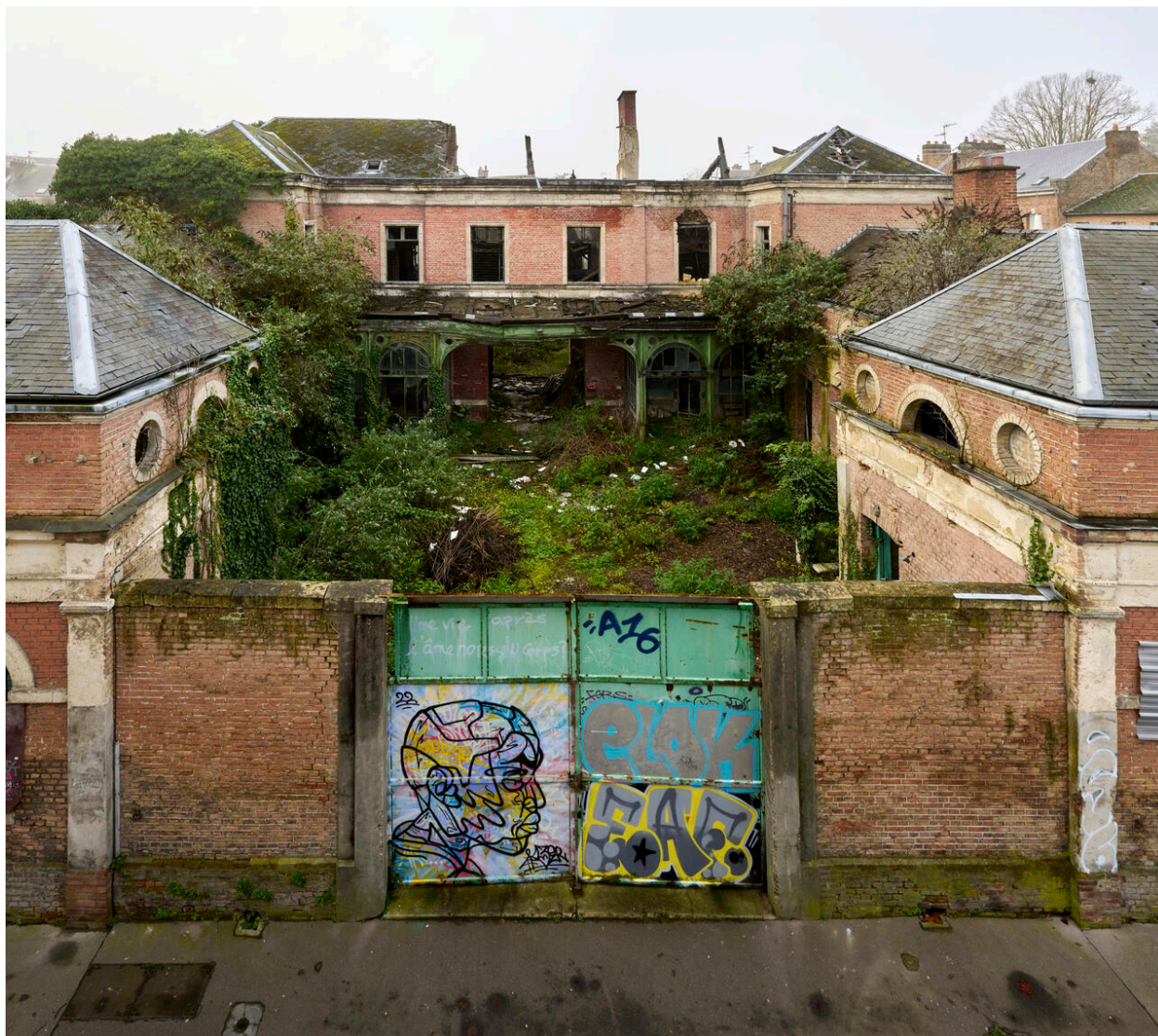
Vue générale depuis la rue Vivien (nord).
