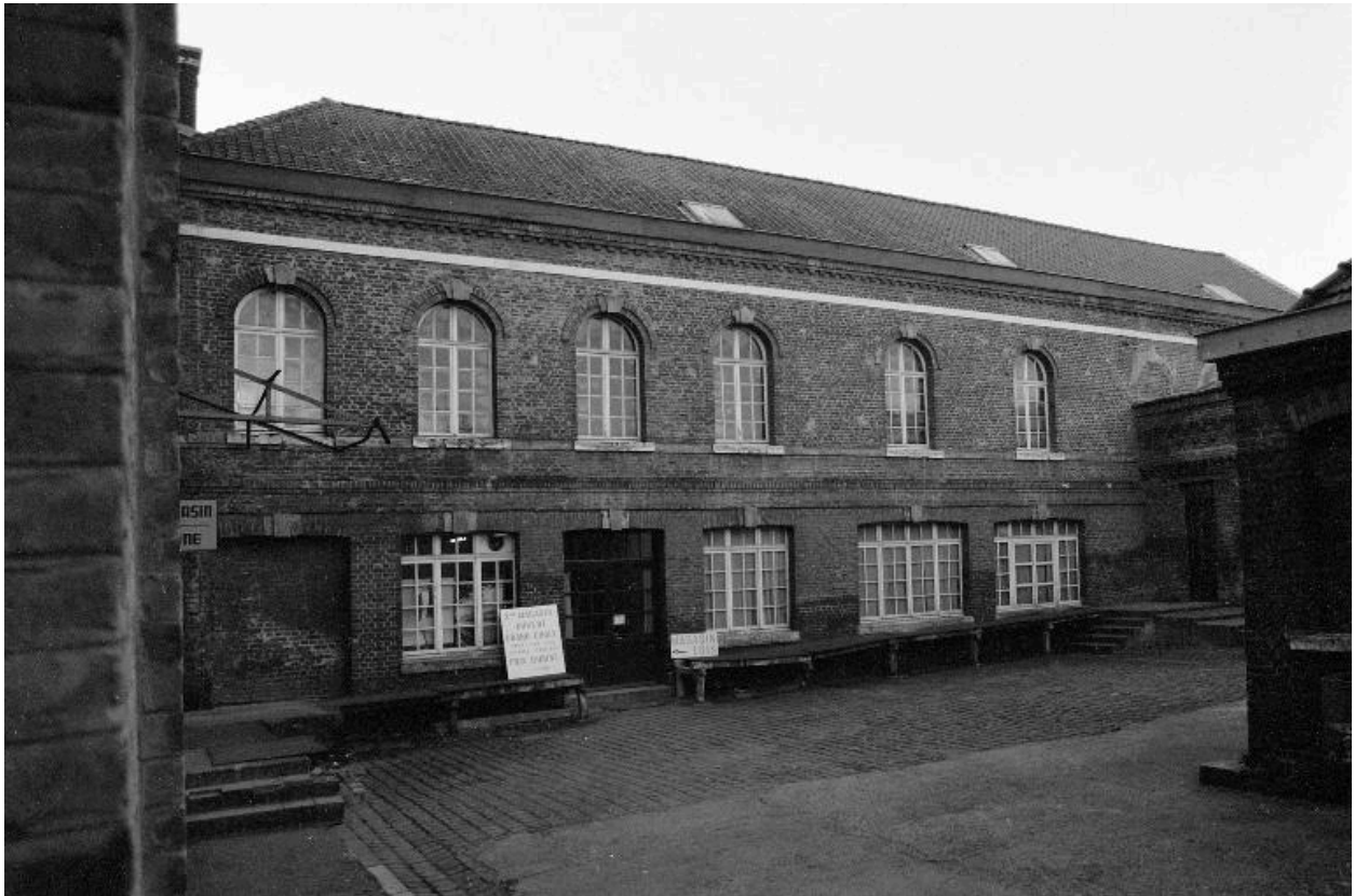
Elévation sur cour de l'atelier de pliage.
