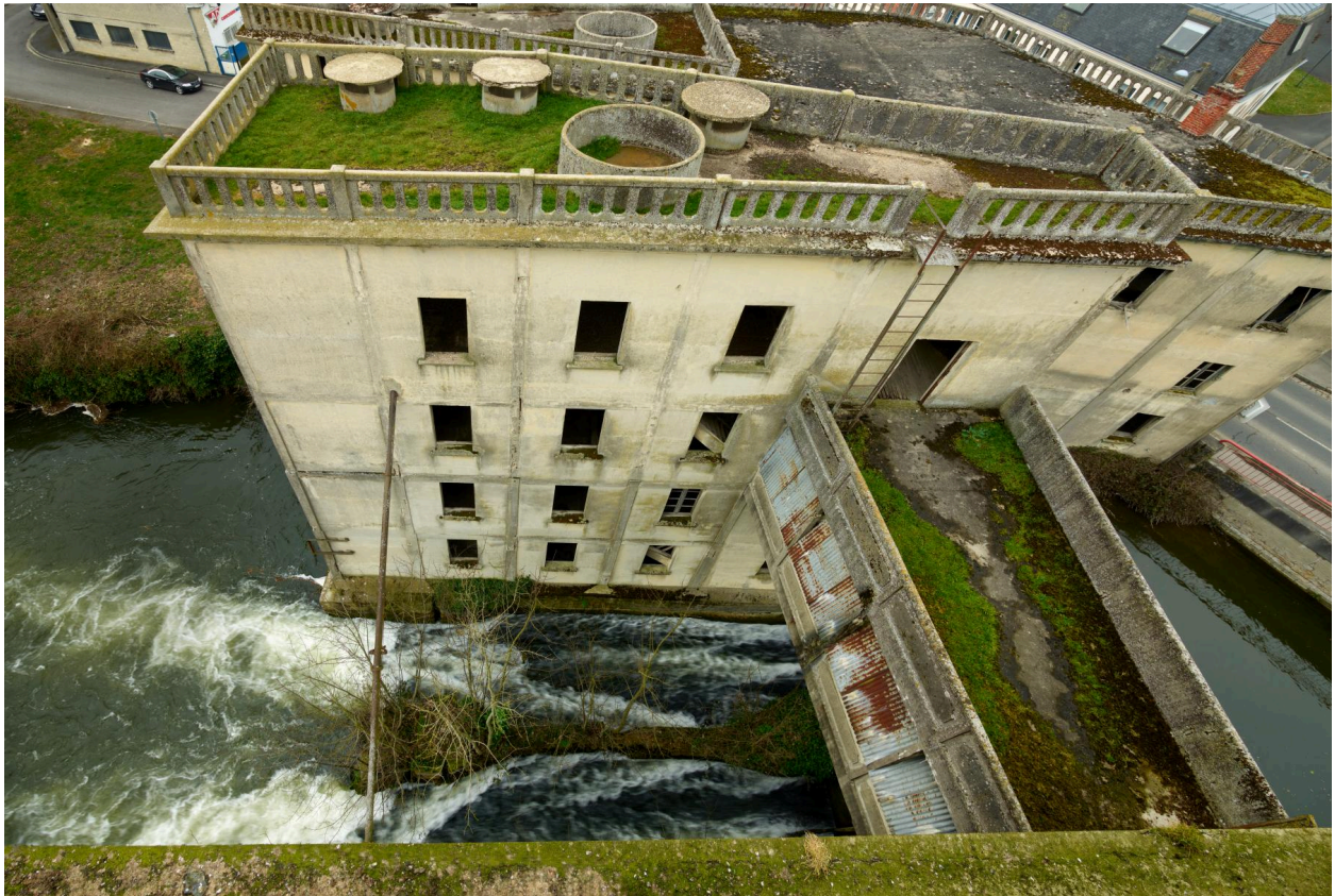
La passerelle reliant les deux corps de bâtiments de la minoterie, vue de dessus.
